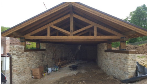
Фиг. 11 Дървена покривна конструкция, „Спонец“ ООД
